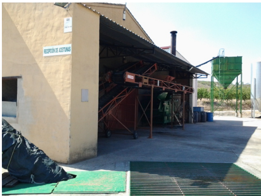
Zona de recepción de aceitunas
